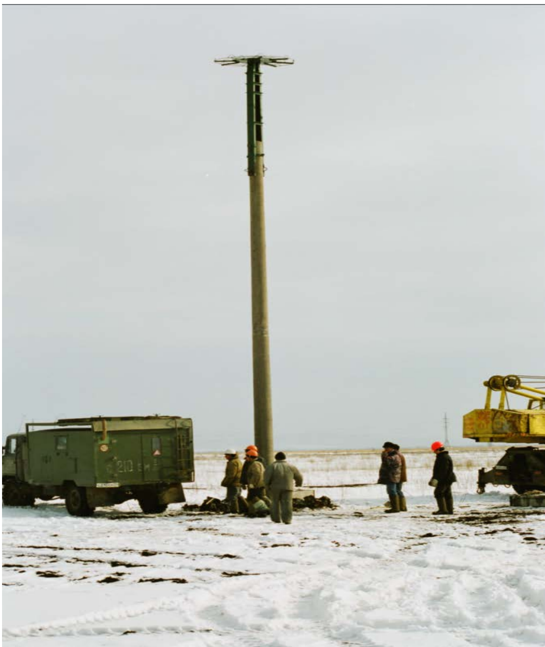
Рис. 8.2.2.3. Специальный оголовок, установленный на опоре линии электропередач в качестве потенциальной платформы для гнездования дальневосточного аиста ( Ciconia boyciana ). Фото Д.В. Коробова.
